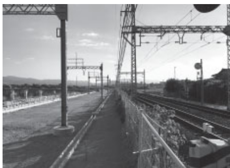
順調に進む近鉄長野線の高架工事
