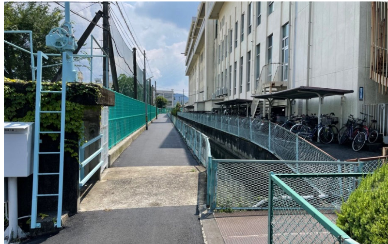
16 東側水路・里道より南方向を見る。
