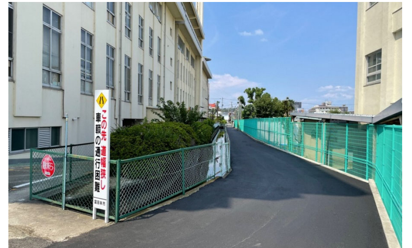
15 東側水路・里道より北方向を見る。
