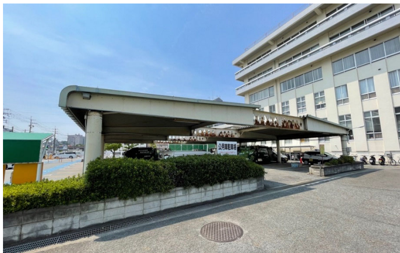
④ 東側水路・里道より南側駐車场上屋を見る。
