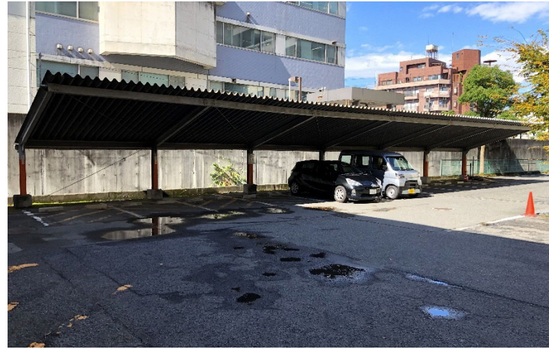
11 中庭より駐車场上屋を見る。
