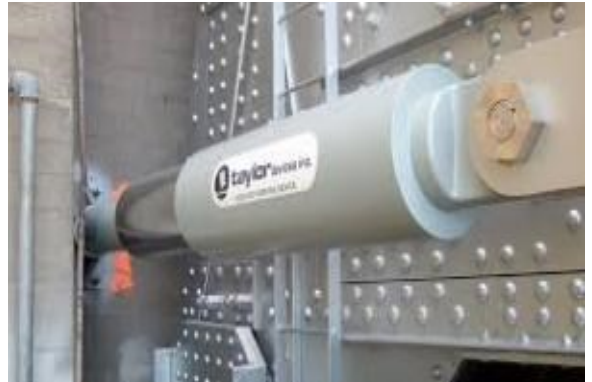
制震ダンパーの実例写真
