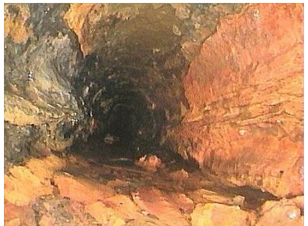
写真 2：雑排水管内部の状況写真：内視鏡調査
