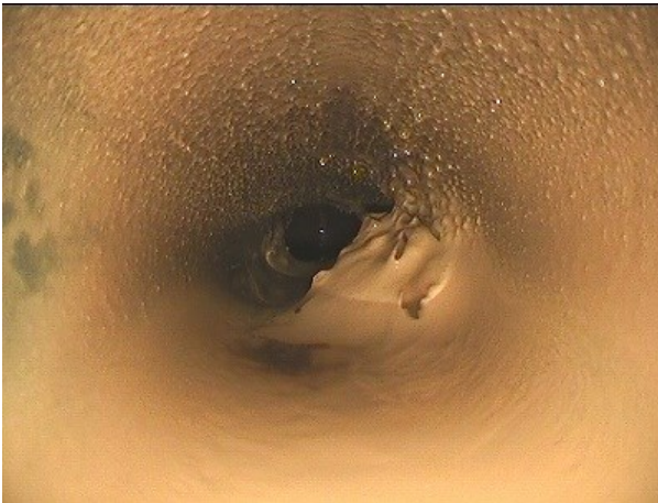
写真1：給水管内部の状況写真：内視鏡調査
