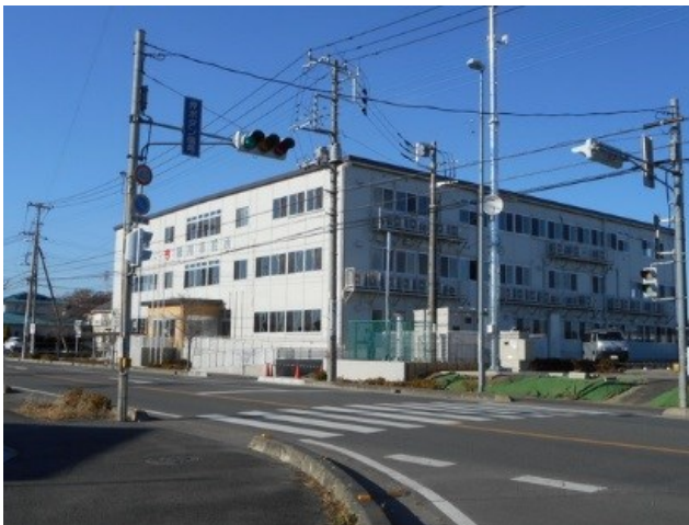
仮庁舎の実例写真
