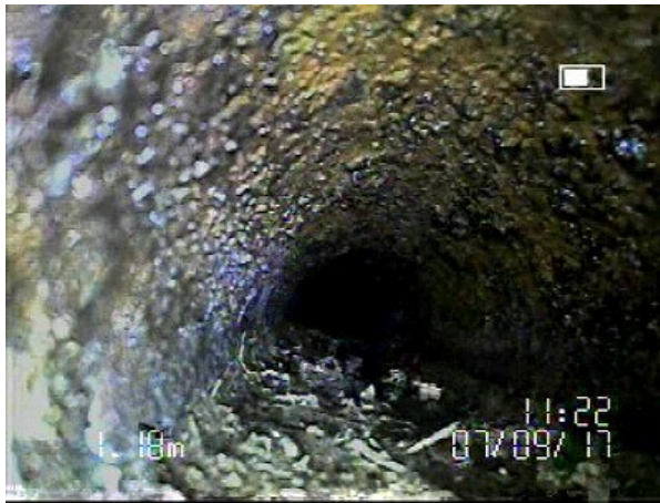
写真 1：汚水排水管内部の状況写真：内視鏡調査
