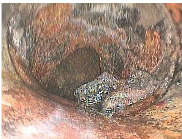
写真 1：雑排水管内部の状況写真：内視鏡調査
