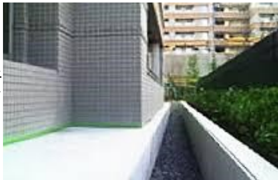
実例写真：建物周囲のスペースの確保が必要である
