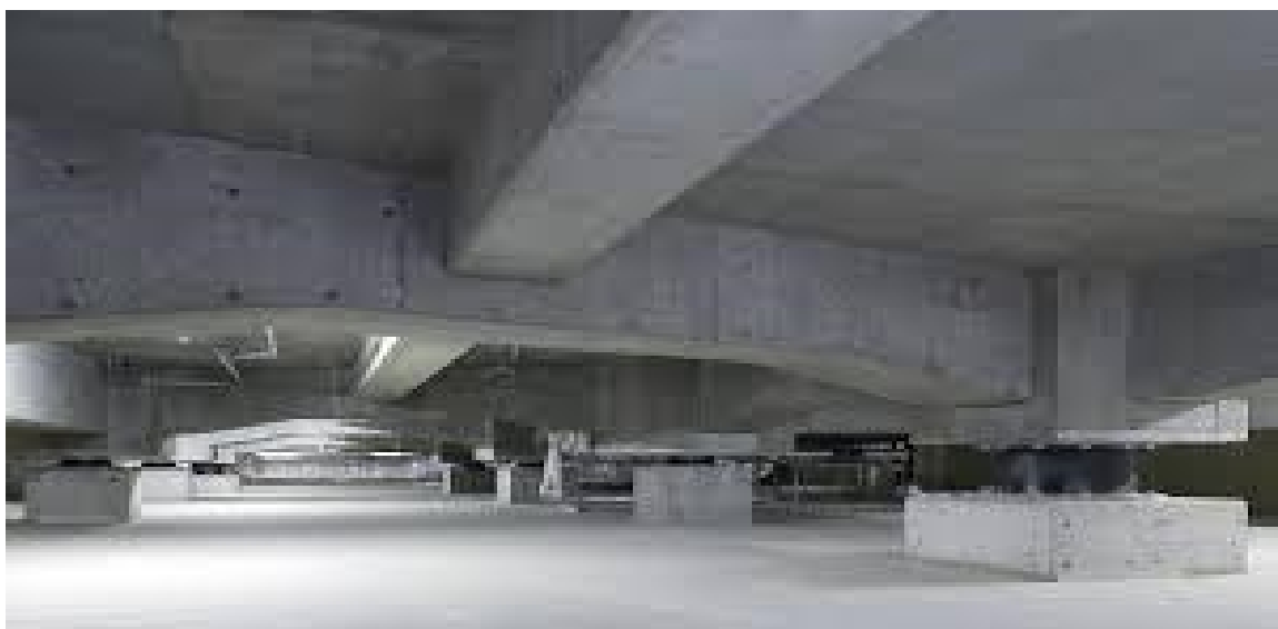
実例写真：建物基礎の下に、さらに基礎を設ける
