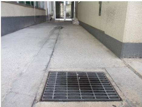
<写真②-5>市本庁舎排水溝
