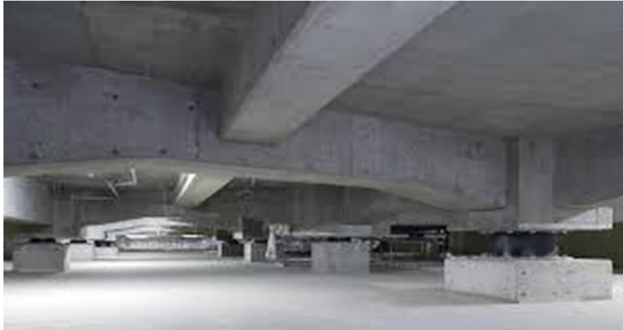
< 5 - 5 > 建物の下に、免震装置を置くための基礎
