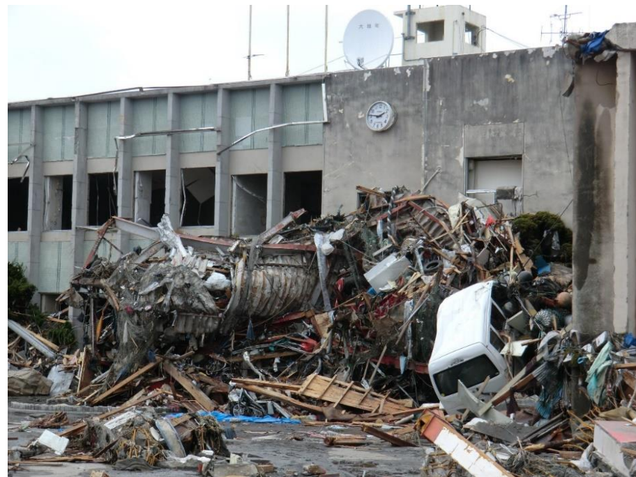
被災した旧大槌町役場庁舎と散乱 している瓦礫の様子 撮影日：平成23年3月16日 撮影者：堺市消防局
