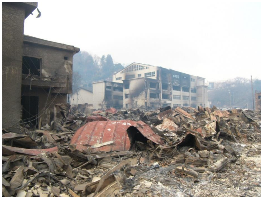
火災にあった旧大槌小学校と周辺 の焼け焦げた瓦礫の様子 撮影日：平成23年3月14日 撮影者：堺市消防局
