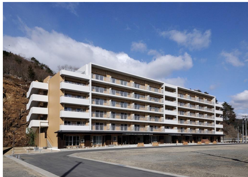
末広町町営住宅 平成28年3月 竣工
