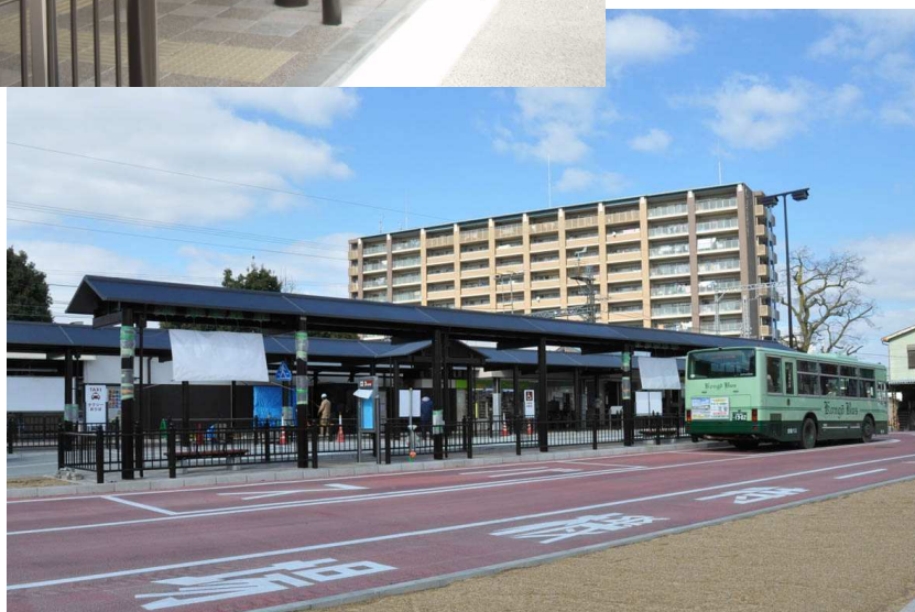
近鉄富田林駅南広場におけるバリアフリー*整備
