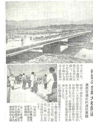
金剛大橋の完成を伝える広報（昭和32年1月）
