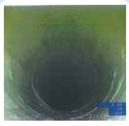
▲修繕後の下水道管
