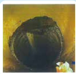
▲修繕前の下水道管
