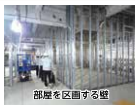
3階部分の施工状況
