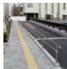
市役所入口スロープ
