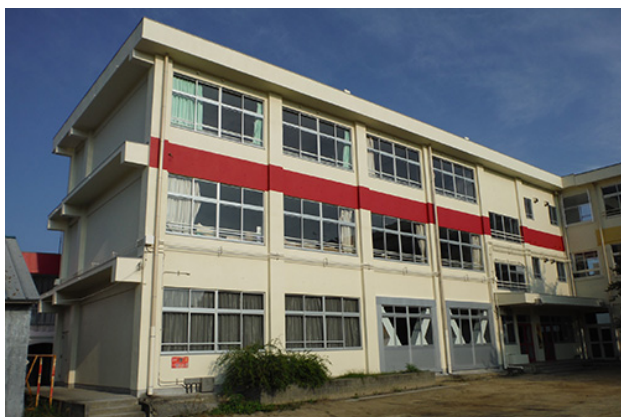
図 2-12 耐震改修工事の実施例
