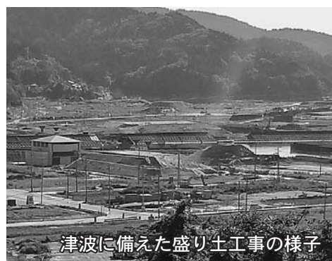
津波に備えた盛り土工事の様子
