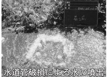
水道管破損による水の噴出
