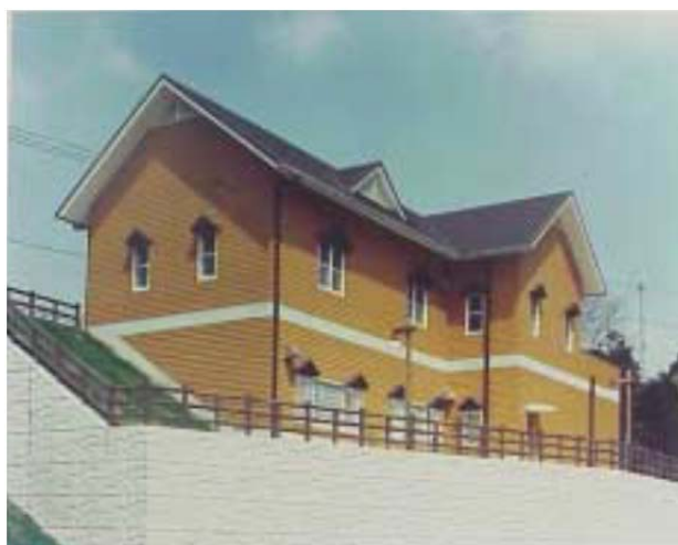
【甘南備・公園ポンプ場】
