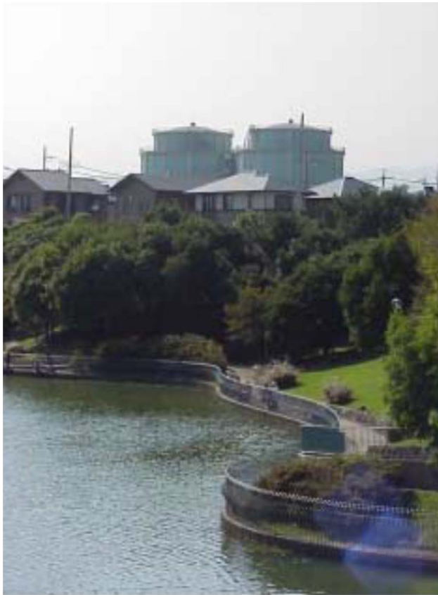
【金剛東配水池】 出典：富田林市水道局 水道事業年報 H13 年度版
