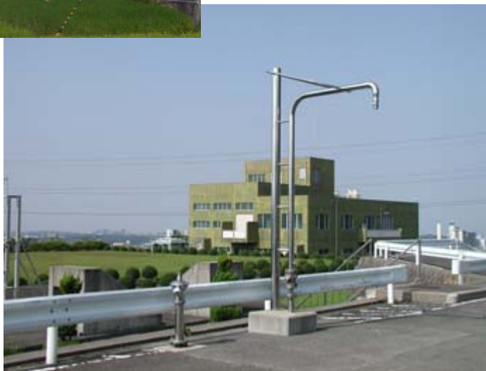
【日野浄水場】 出典：河内長野市ホームページ
