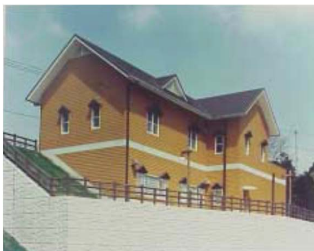
【甘南備・公園ポンプ場】
