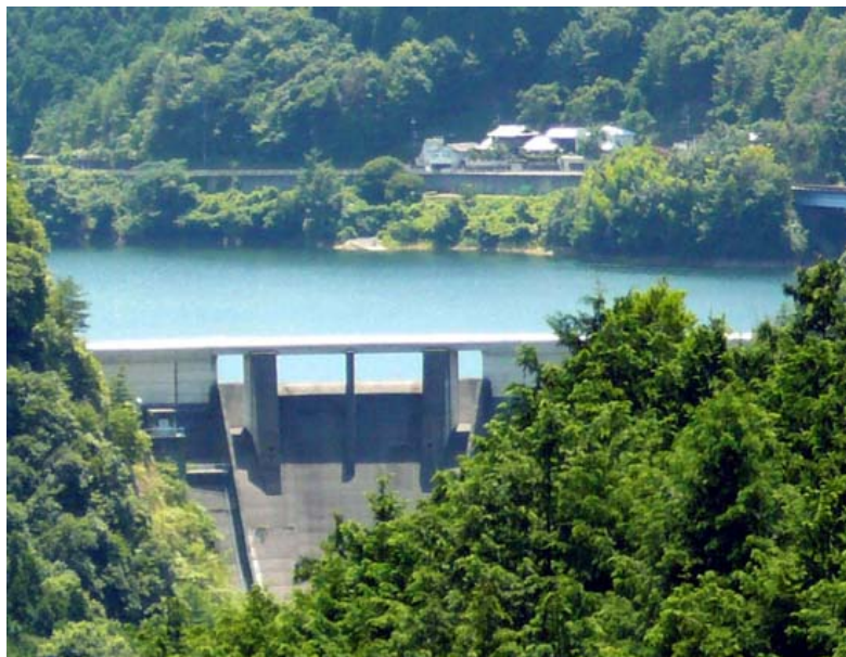
【滝畑ダム】 出典：河内長野市ホームページ
