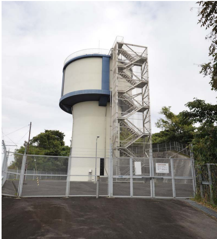
【山中田配水池】
