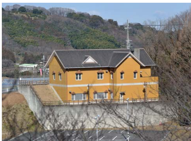
【公園ポンプ場】
