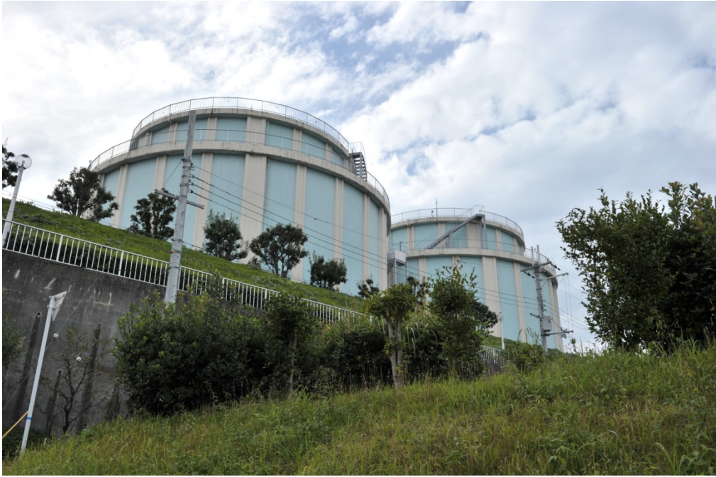
【金剛東配水池】
