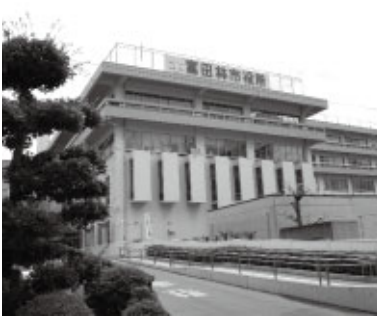
防災拠点としての機能が求められる市庁舎
