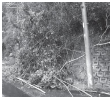
台風により多くの土砂崩れが起きました
