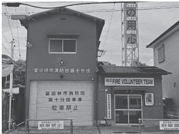
老朽化した消防団車庫の建て替えを求めている
