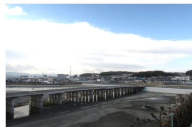
道路整備及び鉄道高架化
