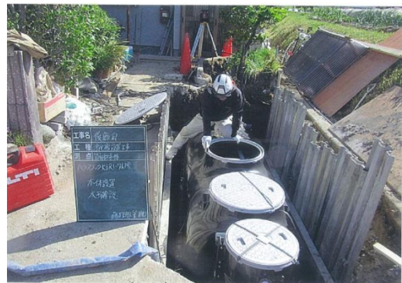
図- 22 浄化槽設置状況
