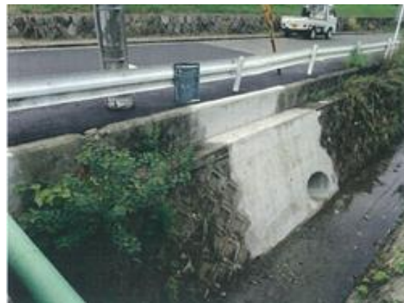
図- 24 金剛排水区内老朽管路の改築整備状況
