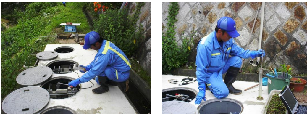
図-15 保守点検状況
