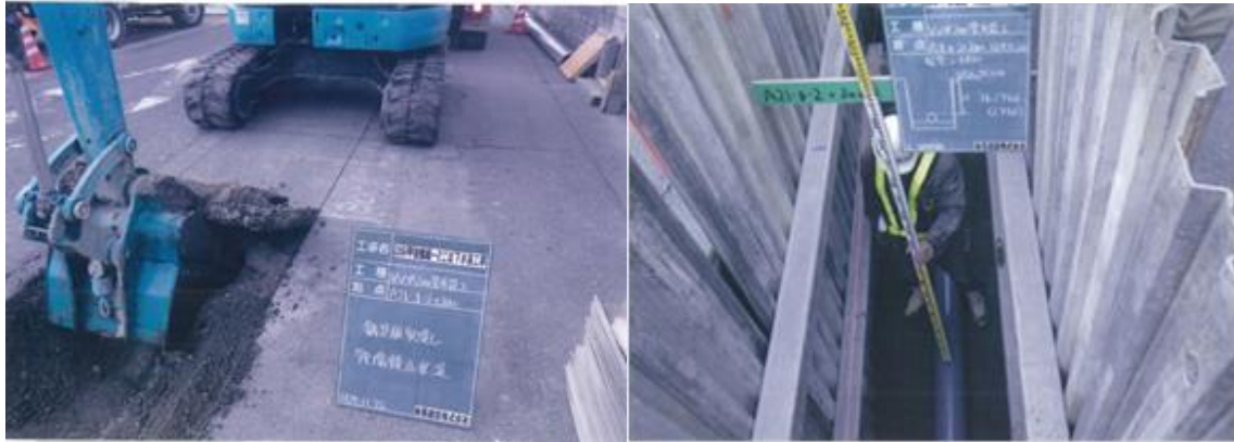
図- 21 未普及地区の汚水管整備状況
