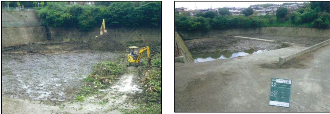
図- 16 梅の里1号調整池の土砂浚渫（左：着工前、右：着工後）
