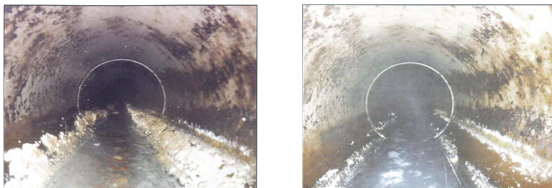
図- 13 汚水管内清掃状況（左：着工前、右：着工後）
