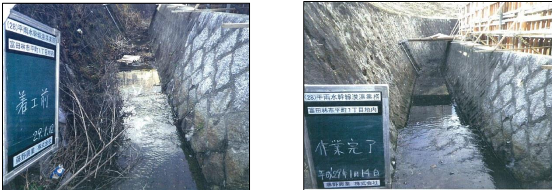
図- 12 水路（平雨水幹線）浚渫状況（左：着工前、右：着工後）
