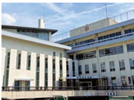
耐震化が検討されている市庁舎
