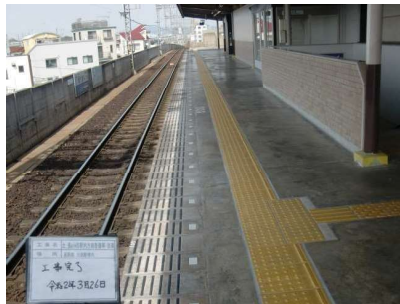
誘導・警告ブロック整備（内方線含む）
