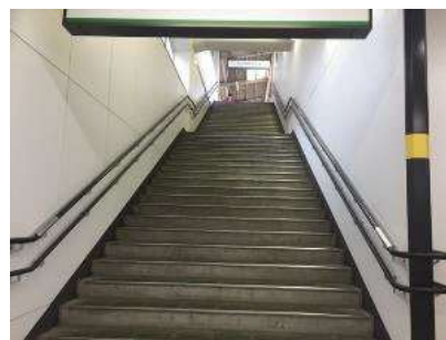
階段手摺改修（2段化）
