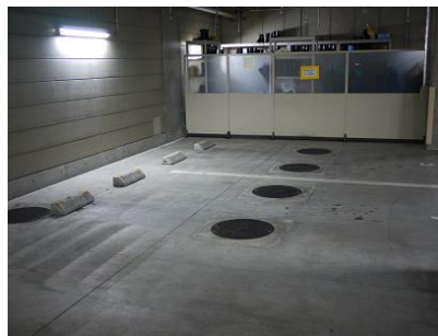
マンホールトイレの設置事例（青梅市役所）
