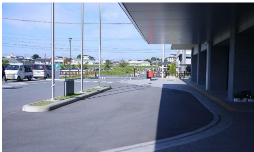
雨に濡れない車寄せ(玉名市役所)
