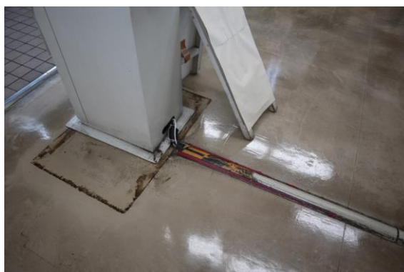
床上配線の様子
