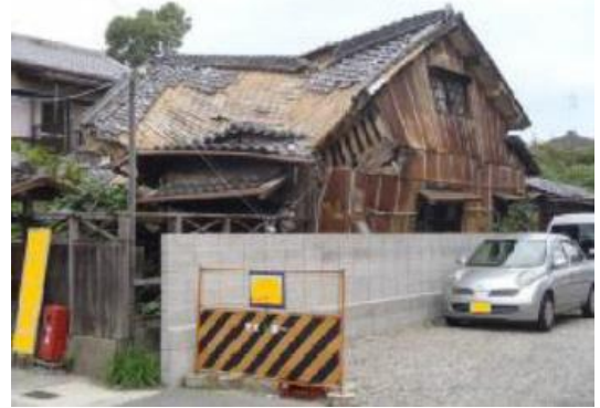
老朽化した危険な空き家 (老朽危険家屋に係るガイドラインの概要(大阪府)より)
