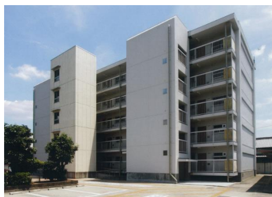
耐震改修をした市営住宅
