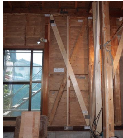
木造住宅の耐震改修工事
