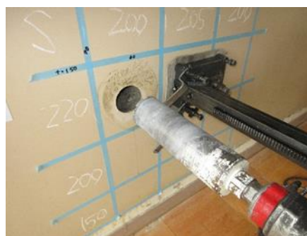
コンクリートコア試験体の穿孔採取
