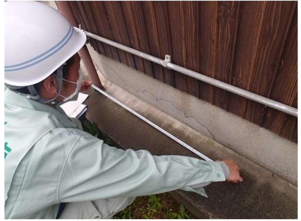
基礎の亀裂計測
