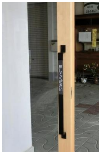
開閉表示を設置
