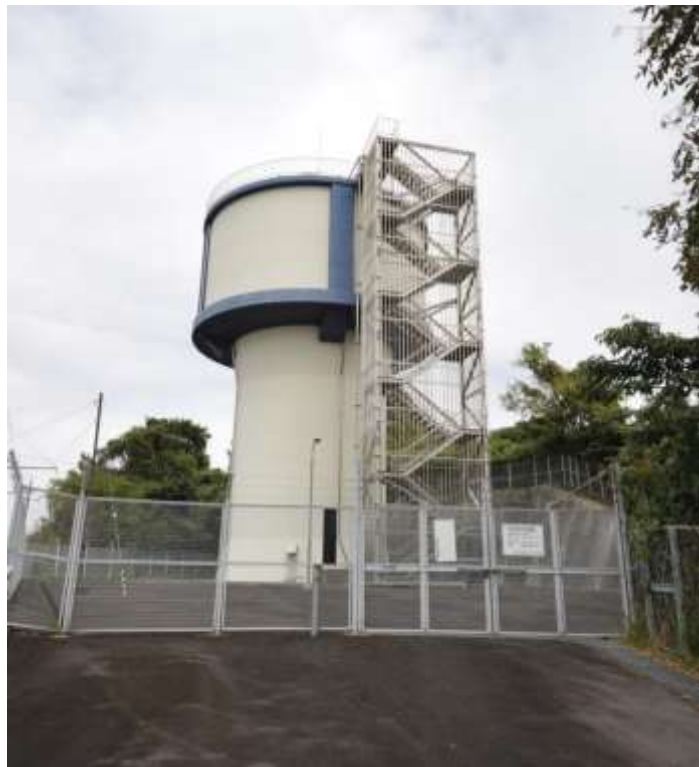
【山中田配水池】
