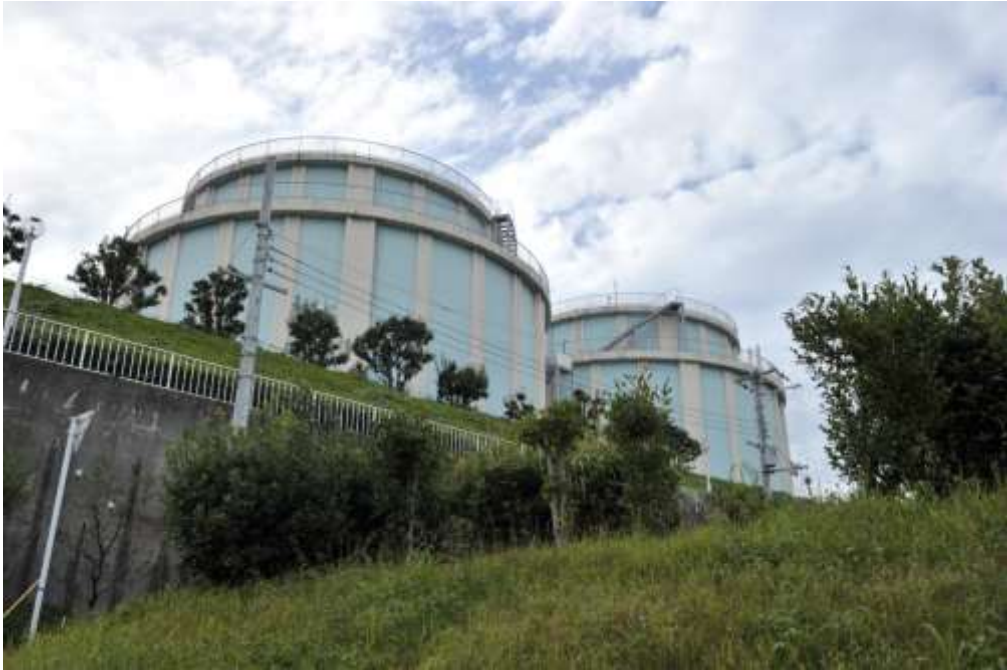
【金剛東配水池】
