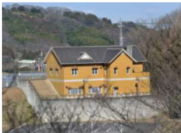
【公園ポンプ場】
