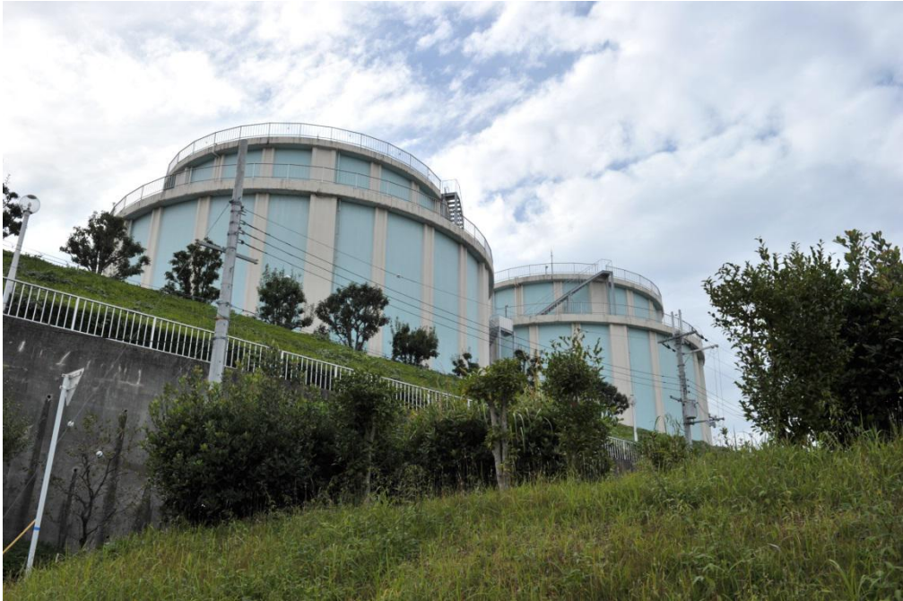
【金剛東配水池】
