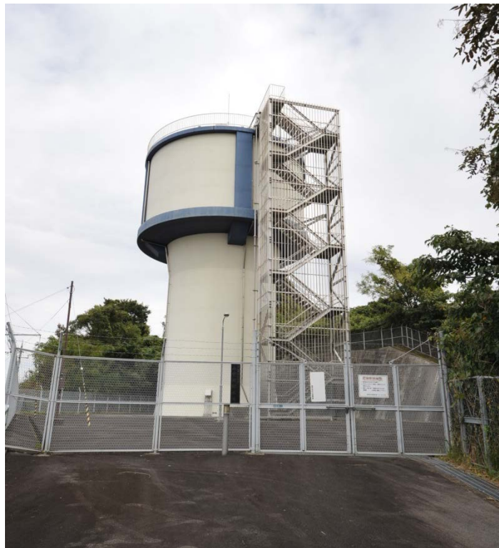
【山中田配水池】
