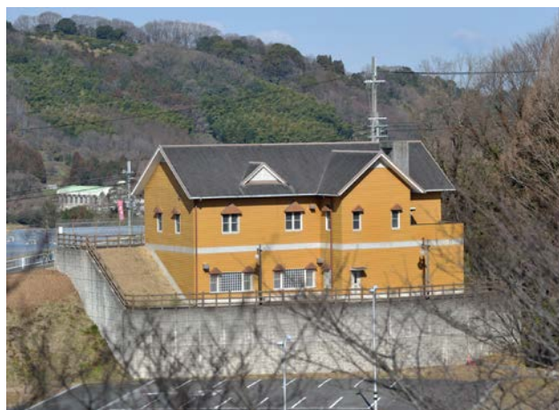
【公園ポンプ場】
