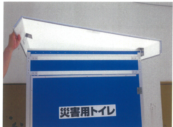
屋根の前後向きを確認して設置する
