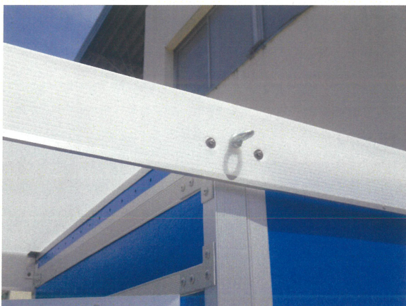
屋根の四隅をボルトで上屋と固定する
