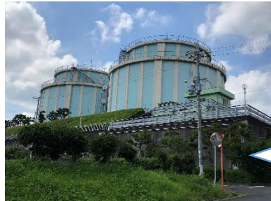
津々山台にある 金剛東配水池
