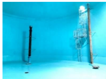
彼方配水池の内部
