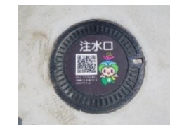
藤沢台小学校で整備が完了したマンホールトイレ
