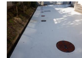
藤沢台小学校で整備が完了したマンホールトイレ
