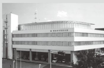
消防本部・消防署の新庁舎が完成
