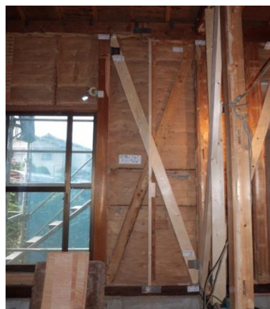
木造住宅の耐震改修工事
