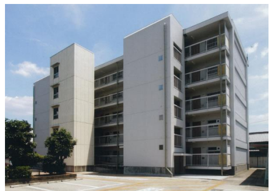
エレベーター設置・耐震改修工事をした 市営住宅（若松団地第10住宅）
