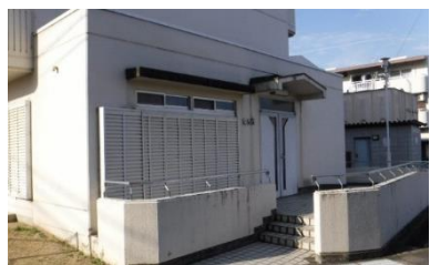
甲田住宅 集会所(1棟1階内)
