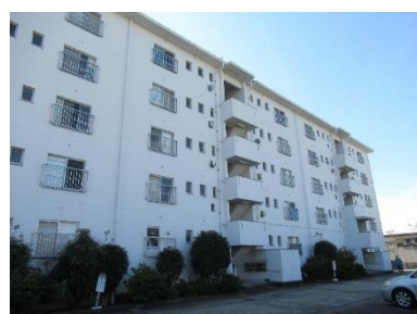
若松団地第12住宅1棟
